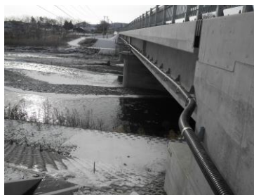
※上水道工事（橋添架管）
